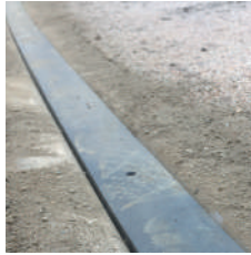
養生後の様子
